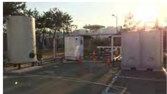
(그림 9) 설계·제작된 48[USRT]의 온배수 히트펌프
